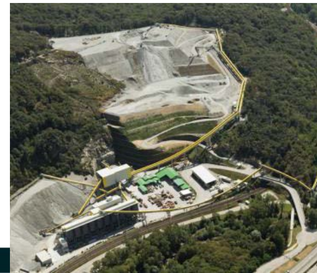
Deponie und Aufbereitungsanlage am Ceneri Basistunnel/Sigirino
